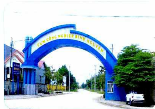
Hình 6.4. Cụm công nghiệp Bình Nguyên (huyện Bình Sơn)
